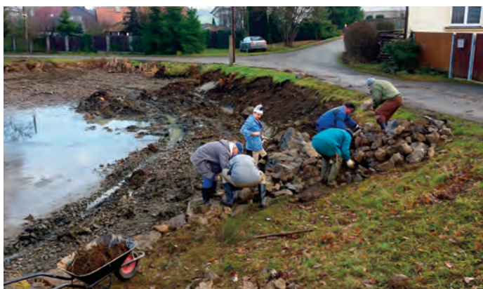
Oprava hráze rybníka v Želčanech 19. 12. 2015
